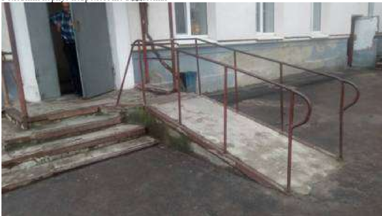
МКЛПЗ – Міська лікарня № 1, вул. Ярмаркова 1 Головний корпус неврологічне відділення
